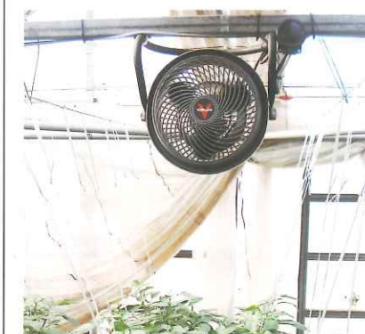
角パイプにサドルバンドで固定
